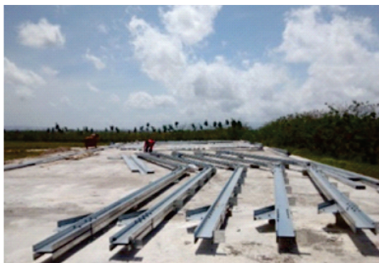
Gambar 10 : Proses Perakitan Portal
